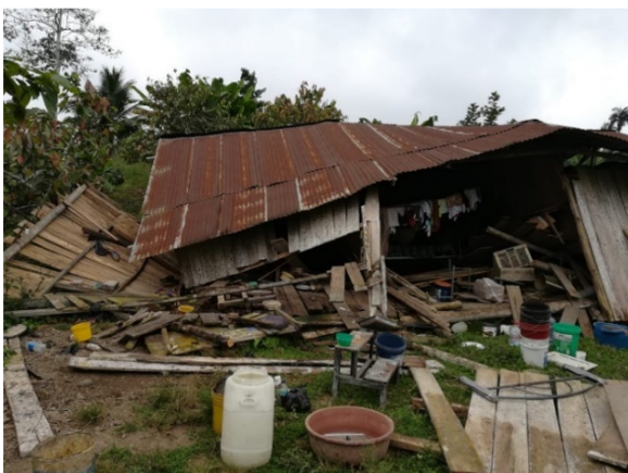
d) Colapso de vivienda en Los Ríos
